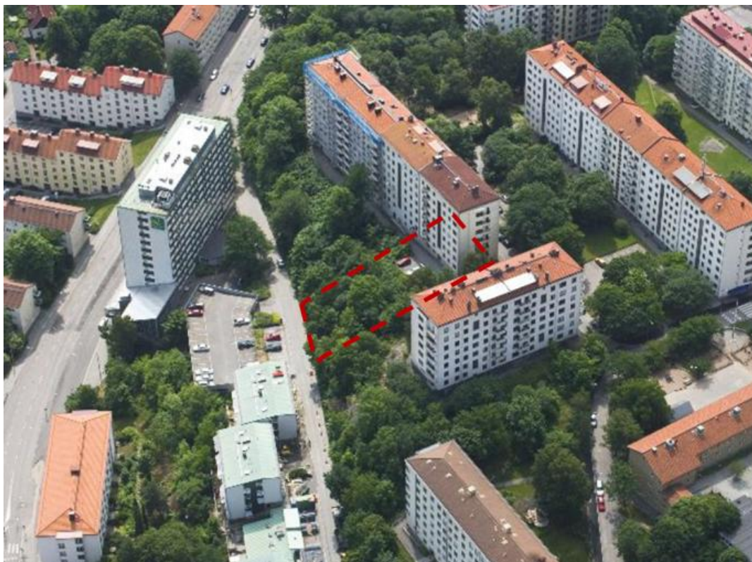
Flygfoto med trädbevuxen bergslänt samt ungefärlig markering av fastigheten Johanneberg 17:6
